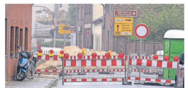
Die Bauarbeiten für die Teilverschwenkung der Hauptstraße in Mülhausen haben begonnen.
